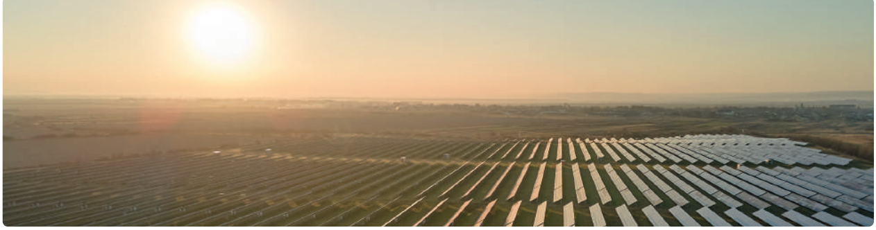
شكل 1.9: الطاقة الكهربائية النظيفة من الألواح الكهروضوئية الشمسية
