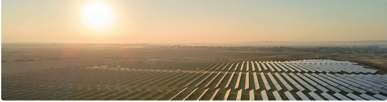
شكل 1.9: الطاقة الكهربائية النظيفة من الألواح الكهروضوئية الشمسية
